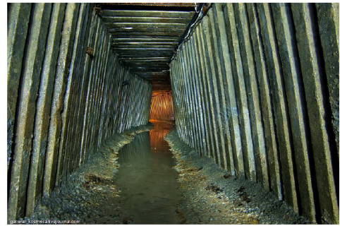
Рисунок 2.40 – Галерейний дренаж
