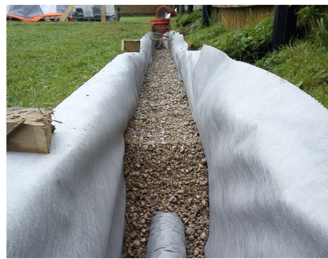
Рисунок 2.39 – Закриті дренажі:
