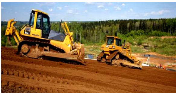
Рисунок 2.144 – Інженерні заходи із відновлення територій відвалів розкривних порід: а) зрізання і переформування відвалів; б) планування схилів відвалів; 1 – існуюча поверхня; 2 – породи, що зберігаються або насипний ґрунт; 3 – проектна поверхня
