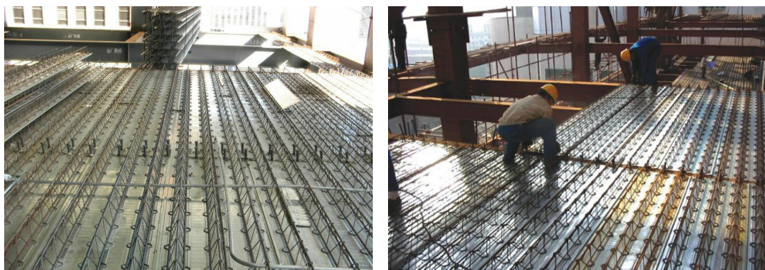
Рисунок 2.10. Пример использования стального настила с фабричной приваркой арматурного каркаса
