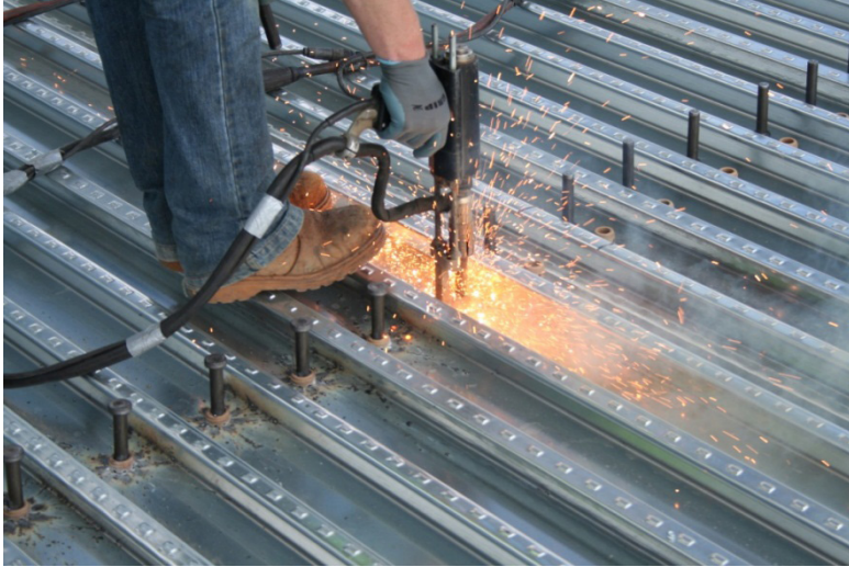
Рисунок 8.29. Приварка ряда стад-болтов непосредственно через профнастил
