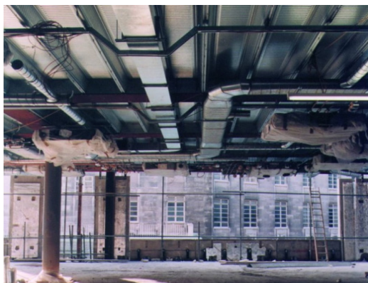
(1) Разводка сетей под перекрытием
