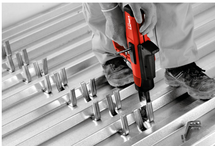
Рисунок 8.33. Крепление анкерных упоров Hilti X-HVB при помощи порохового пистолета
