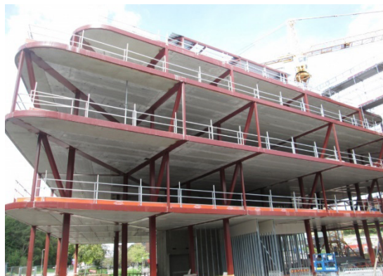
Рисунок 1.8. Пример перекрытий пониженной высоты на основе HQ- и WQ-балок
