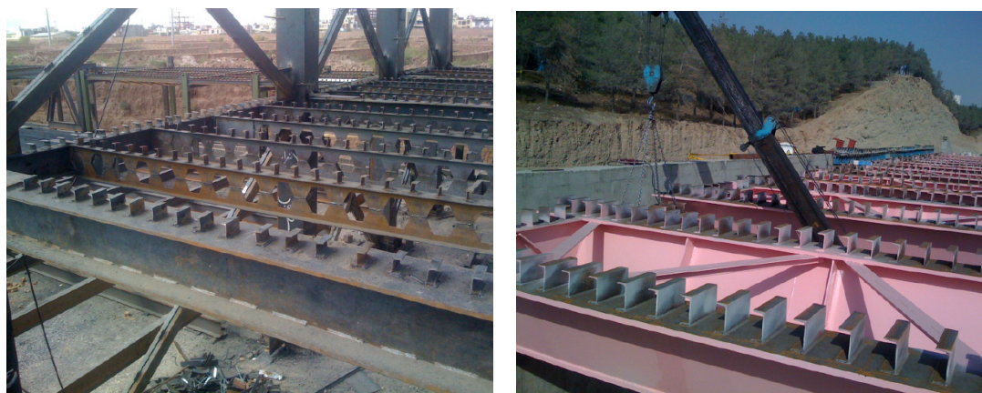
Рисунок 5.43. Примеры гибких упоров в виде прокатных швеллеров без подкрепляющих ребер
