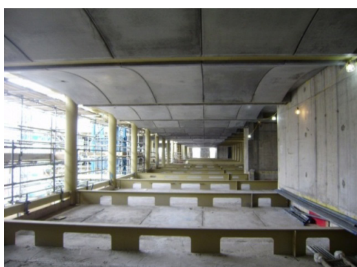
(3) Организация высокого фальшпола в перфорациях балок
