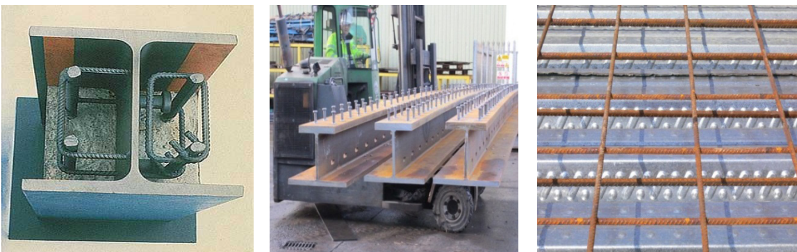
Рисунок 1.11. Примеры сталежелезобетонных колонн, балок и плит
