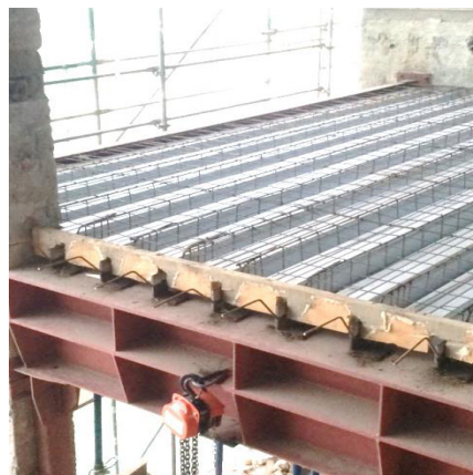
Рисунок 5.44. Угловой упор с арматурным анкером: схема работы и пример использования в перекрытии здания в г. Киев
