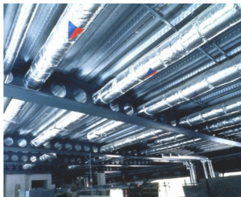
(2) Разводка сетей в перфорациях балок перекрытия под плитой
