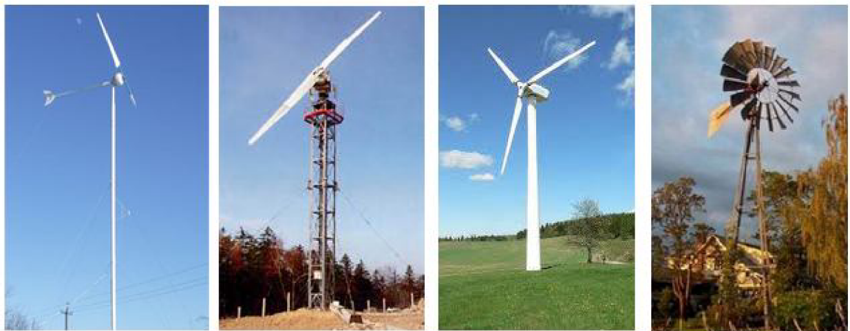
а) однолопатева; б) дволопатева; в) трилопатева; г) багатолопатева Рис. 8.4. ВЕУ з горизонтальною віссю обертання
