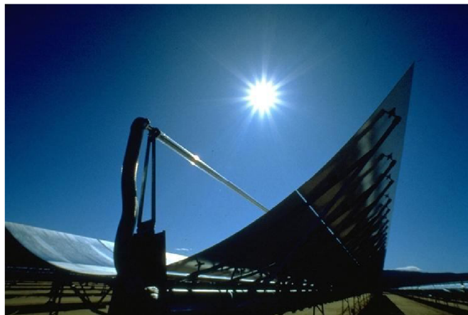
Рис. 7.1. Параболоциліндричний концентратор
