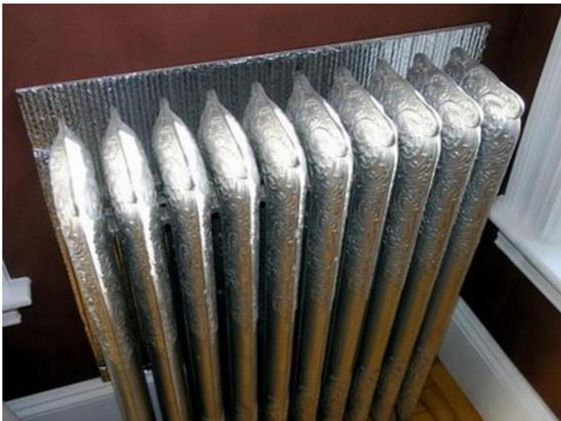
Рисунок 3. Пример установки теплоотражающего экрана
