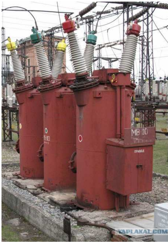
Рис.15 Баковий масляний вимикач (1 – корпус вимикача, 2 – масло, 3 – високовольтний ввід, 4 – пружина приводу, 5 – система переміщення рухомого контакту, 6 – нерухомі контакти, 7 – рухомий контакт)
