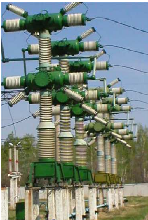
Рис.17 Повітряний вимикач (1 – дугогасильні камери, 2, 3 – опорні ізолятори, 4 – прохідні ізолятори, 5 – повітропровід, 6 – ділянки напруги)
