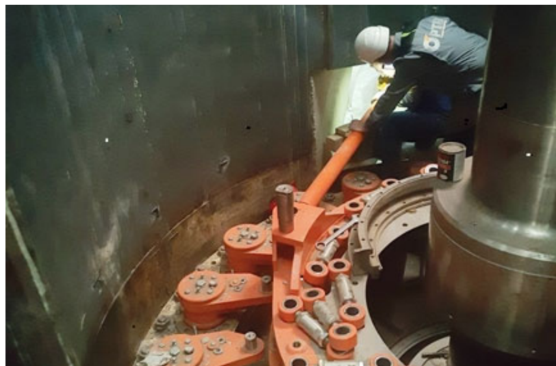
Рис. 3.35 - Конструкція приводу напрямного апарату
