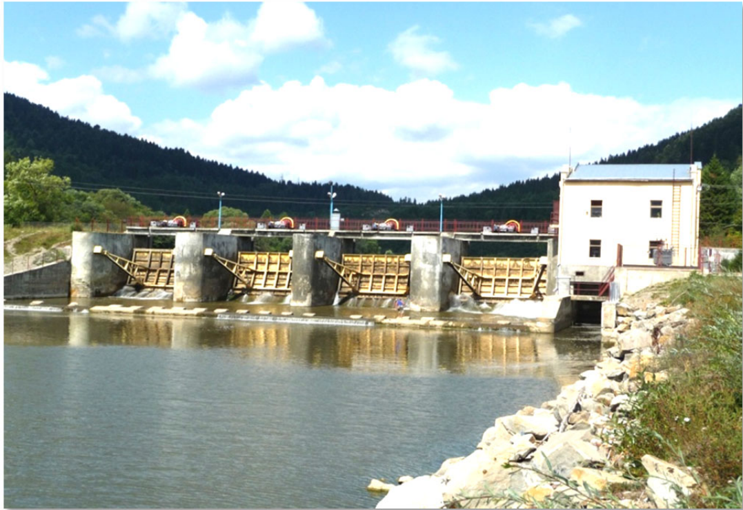
Рис. 2.16 – Руслова гідроелектростанція(Яворська мала ГЕС, Львівська обл., р. Стрий потужність 450 кВт)
