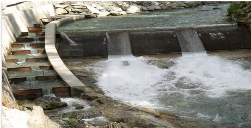
Рис.1.14 – Вертикальний канал з басейнами
