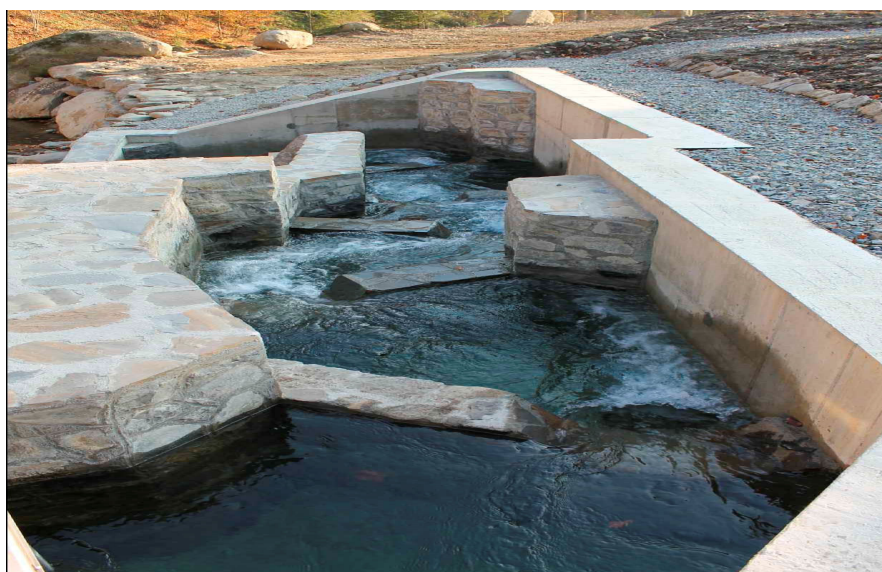
Рис. 1.12 – Рибохід типу вертикальний канал з басейнами Приклад природнього бокового каналу показано на рис.1.13.
