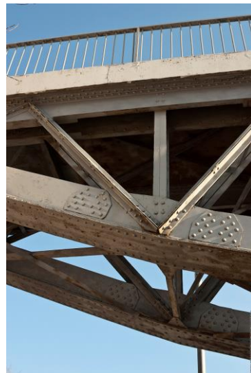
Рис. 24.4. Фрагмент металокопструкції мосту, що виконаний заклепковим з'єднанням
