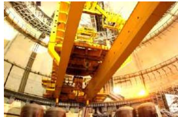
Полярний кран вантажопідіймальною до 360 т енергоблоку № 2 Нововоронезької АЕС-2 (РФ)
