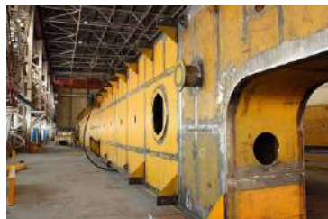
Виготовлення моста (балки) полярного крана на майданчику механоскладального цеху № 5 АО "Тяжмаш" (м. Сизрань, РФ)
