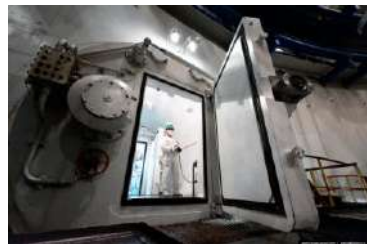
Шлюз основний гермооболонки енергоблоку № 1 Балаковської АЕС (РФ)
