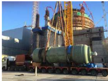
Компенсатор тиску енергоблоку № 2 Ленінградської АЕС-2 (РФ)
