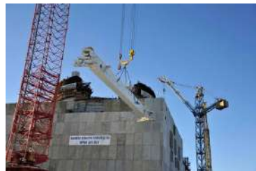
Підйом з наступним встановленням балки вагою 110 т полярного крана енергоблоку № 4 Ростовської АЕС (РФ)
