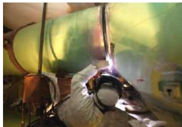
Процес приварювання труби до ГЦН на енергоблоці № 2 Нововоронезької АЕС-2 (РФ)
