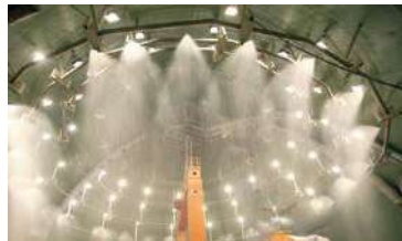
Перевірка працездатності спринклерної системи енергоблоку № 2 Нововоронезької АЕС-2 (РФ)
