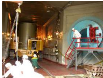
Зона завантаження транспортного коридору енергоблоку № 4 Запорізької АЕС (Україна)
