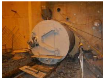
Монтаж шлюзу основного вагою понад 22 тонни енергоблоку № 1 Ленінградської АЕС-2 (РФ)
