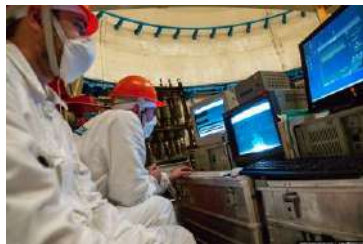
Контроль теплообмінної поверхні труб від накипу та відкладень парогенератора ПГВ-1000М енергоблоку № 2 Балаковської АЕС (РФ)
