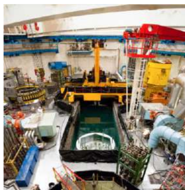
Басейн мокрого перевантаження ядерного палива енергоблоку № 1 Балаковської АЕС (РФ)
