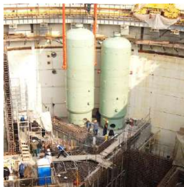
Монтаж гідроємностей CAO3 на позначці + 28,10 енергоблоку № 1 Нововоронезької АЕС-2 (РФ)
