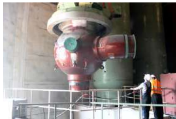
Монтаж равлика ГЦН-195М енергоблоку № 1 Нововоронезької АЕС-2 (РФ)
