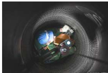
Процес розвальцювання теплообмінних труб всередині колектора парогенератора ПГВ-1000М
