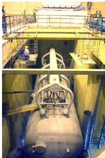
Монтаж основного обладнання парогенерувальної установки енергоблоку № 1 Ленінградської АЕС-2 (РФ)
