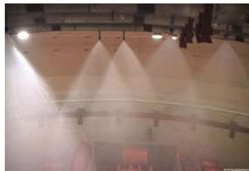
Випробування спринклерної системи енергоблоку № 4 Рівненської АЕС (Україна)
