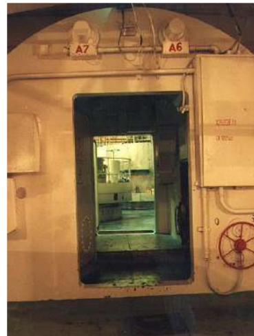
Шлюз основний гермооболонки енергоблоку № 1 Запорізької АЕС (Україна)
