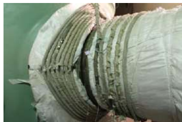
Теплоізоляція ГЦТ енергоблоку № 1 Нововоронезької АЕС-2 (РФ)
