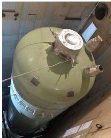
Верхня частина компенсатора тиску енергоблоку № 4 Ростовської АЕС (РФ)
