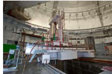
Перевантажувальна машина МПС-В-1000 енергоблоку № 1 Волгодонської АЕС (РФ)
