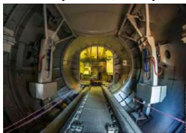
Внутрішній вигляд шлюза транспортного гермооболонки енергоблоку № 7 Нововоронезької АЕС (РФ)
