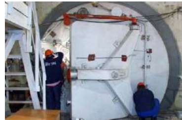
Монтаж шлюзу основного гермооболонки енергоблоку № 4 Ростовської АЕС (РФ)
