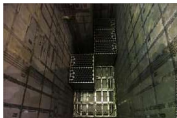
Стелажі у басейні витримки ВЯП енергоблоку № 6 Нововоронзької АЕС (РФ)
