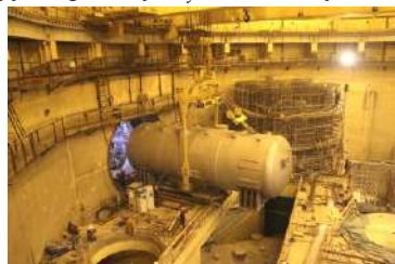
Монтаж парогенератора ПГВ-1000МКП у гермооболонці з реактором ВВЕР-1200 енергоблоку № 1 Ленінградської АЕС-2 (РФ)
