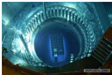
Завоєний водою шахтний об'єм реактора ВВЕР-1000 під час перевантаження ядерного палива на енергоблоці № 2 Балаковської АЕС (РФ)
