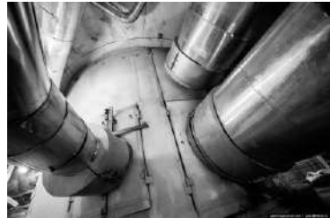
Під'єднання трубопроводів ГЦК до реактора ВВЕР-1000 енергоблока № 2 Балаковської АЕС (РФ)
