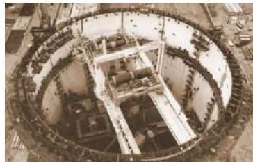
Полярний кран енергоблоку № 1 Запорізької АЕС (Україна)
