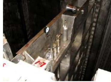
Гідрозатвор з прольотом 1,5 м басейна витримки енергоблока № 3 з реактором ВВЕР-1000 Тяньваньської АЕС (Китай)
