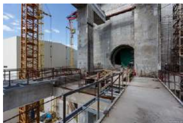
Місце встановлення транспортного шлюзу на позначці + 26,00 у гермооболонці енергоблоку № 1 Білоруської АЕС (Білорусь)
