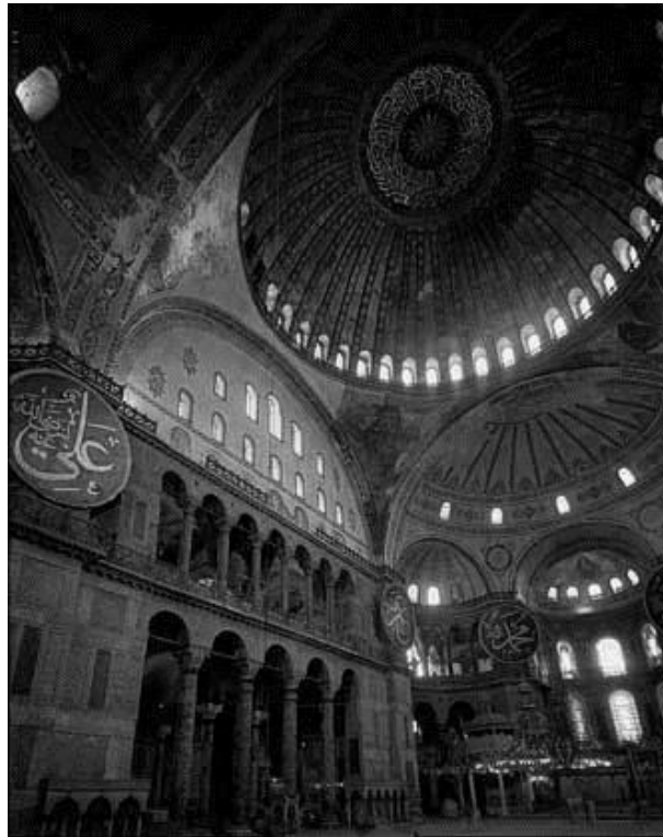
Малюнок 1.5.1 - Тип храму, в якому центральне приміщення робилося великим і перекривалося куполом.
