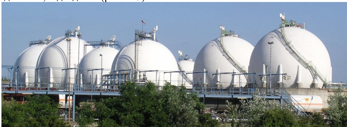
Рисунок 11.12 – Резервуари для зберігання нафти (кулястий)
