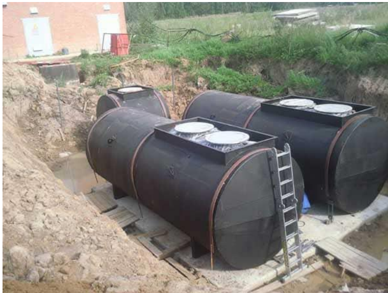
Рисунок 11.13 – Підземні резервуари для нафтопродуктів https://sbk.ltd.ua/uk/tehnichna-dokumentatsija/100-rezervuary-ukraina-emkosti-podzemnye-drenazhnye-ep-epp.html
