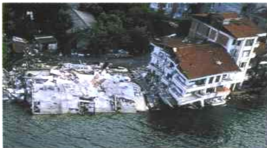
Рис. 14.3. Наслідки цунамі на острові Окусірі
