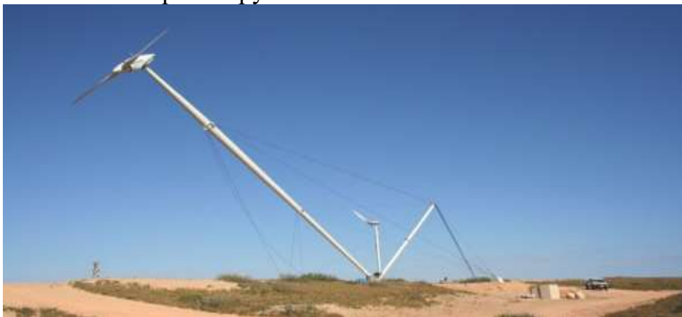
Рис. 18.9. Підйомна вежа ВЕУ на ВДЕС Coral Bay
