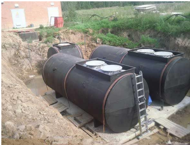
Рисунок 11.13 – Підземні резервуари для нафтопродуктів [48]
