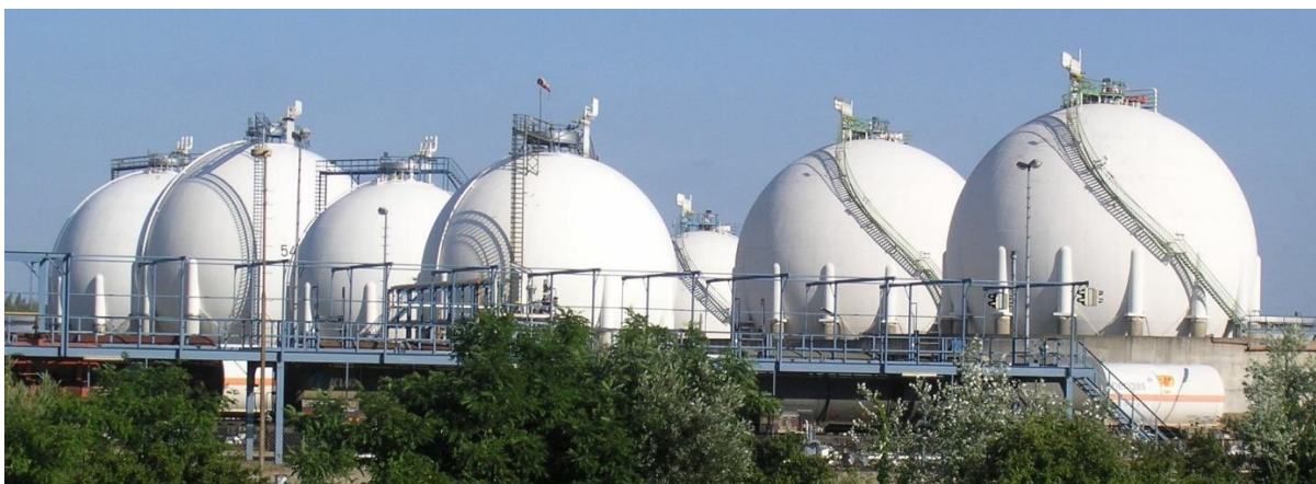
Рисунок 11.12 – Резервуари для зберігання нафти (кулястий)
