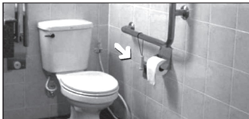
Рис. 34: Система аварійної сигналізації для туалету
