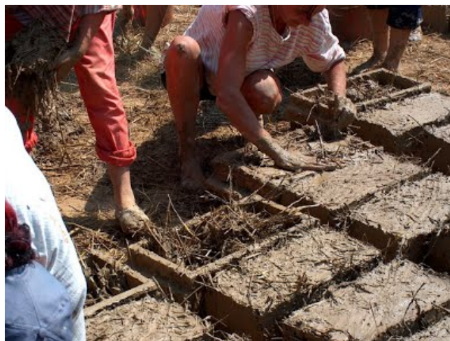
Рис. 1.1. Формування композитного будівельного матеріалу у формі цегли
