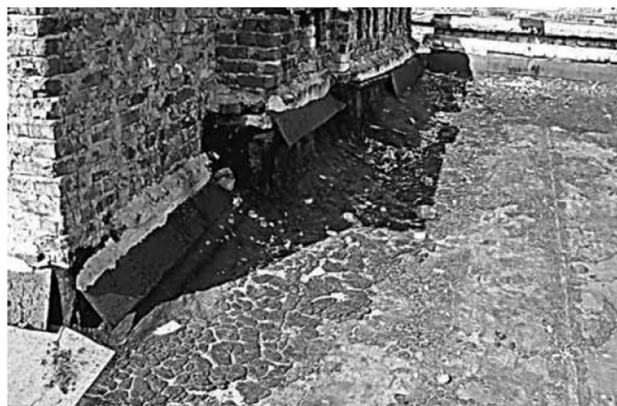
Рис.2.4. Зовнішній вигляд покрівлі з рулонних матеріалів після тривалої експлуатації
