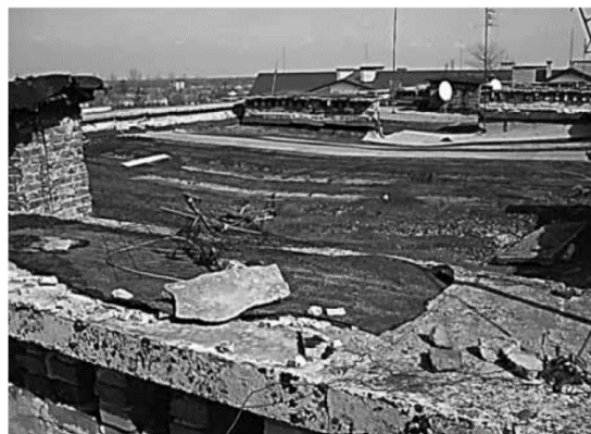
Рис.2.4. Зовнішній вигляд покрівлі з рулонних матеріалів після тривалої експлуатації
