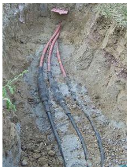
Рис. 6.3. Високовольтні кабелі в траншеї
