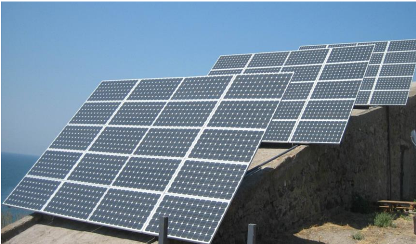
Рис. 3.9. Фотоелектрична станція потужністю 10 кВт на острові Зміїний
