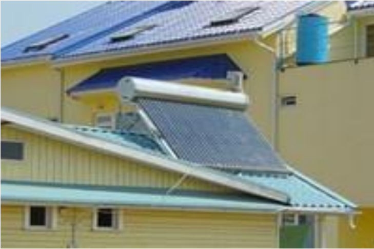
Рис. 3.14. Термосифонна система сонячного теплопостачання з природною циркуляцією теплоносія
