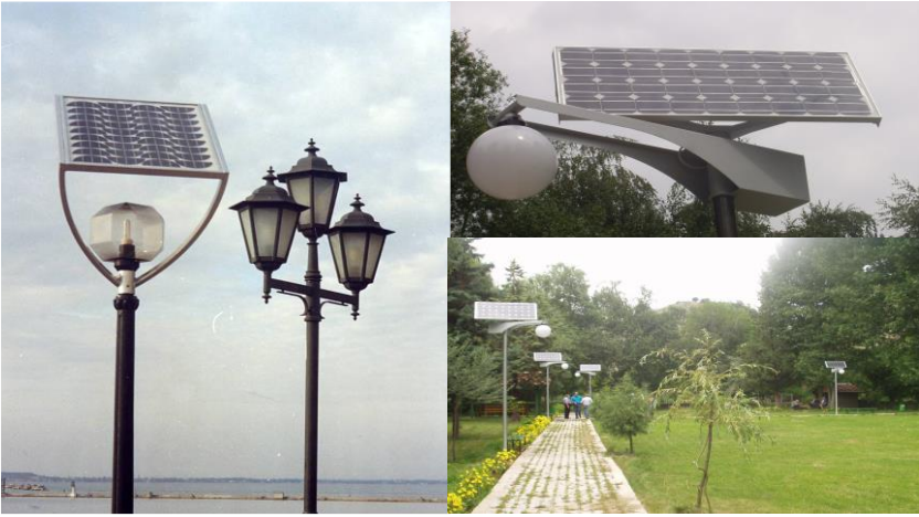
Рис. 3.8. Система фотоелектричного освітлення ботанічного саду м. Києва
