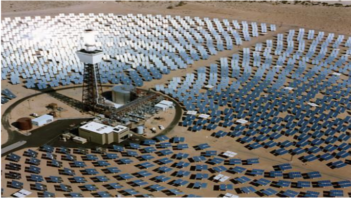
Рис. 3.3. Сонячна теплодинамічна електростанція
