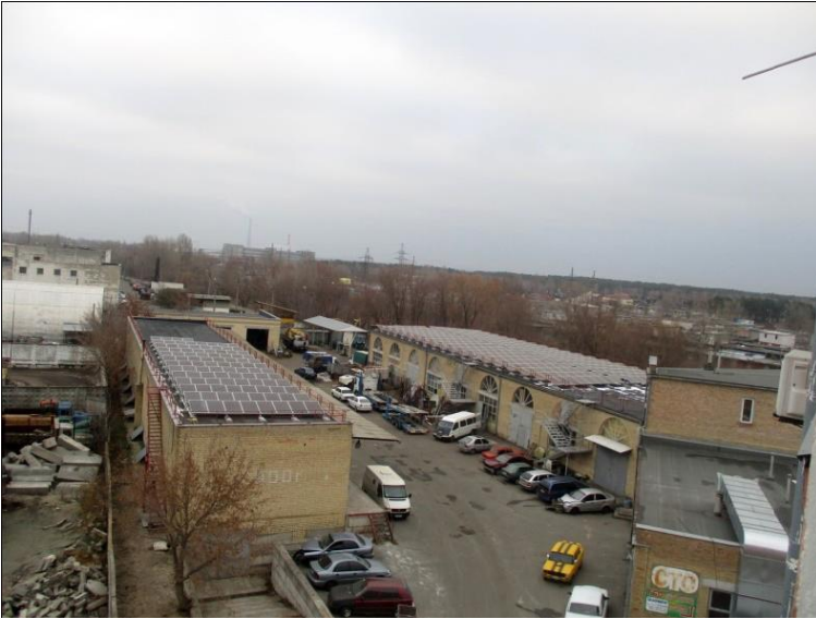
Рис. 3.11. Перша в м. Києві промислова сонячна дахова фотоелектрична станція
