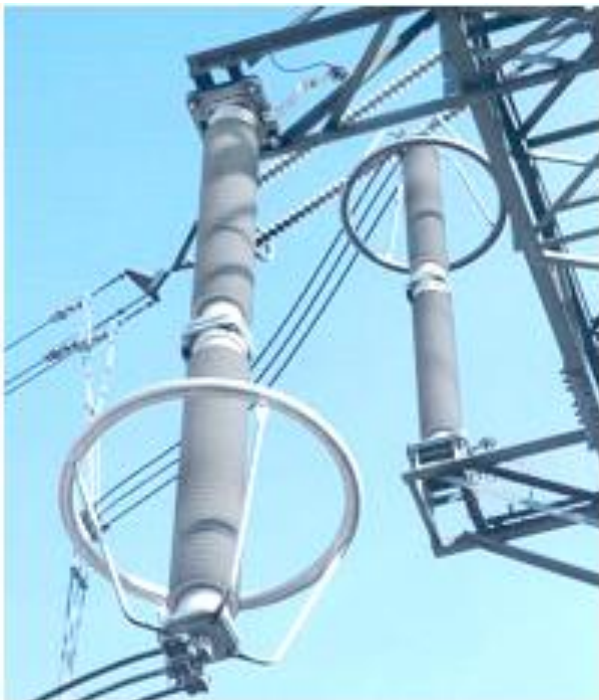
Рисунок 9.11 – Нелінійні обмежувачі перенапруг в експлуатації
