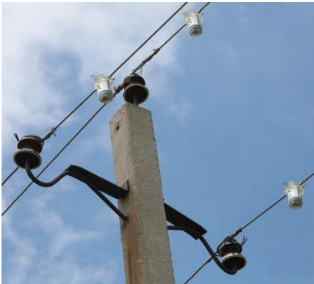
Рисунок 8.12 – Індикатори КЗ на проводах ЛЕП
