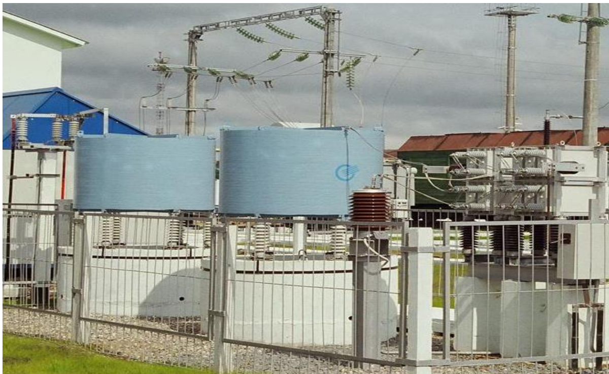
Рисунок 5.16 – Силовий пристрій фільтрації гармонік та компенсації реактивної потужності мережі змінного струму
