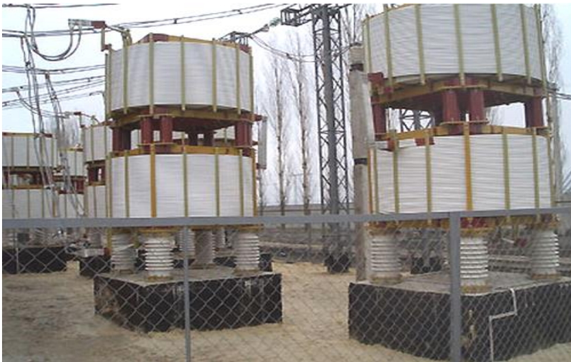
Рисунок 5.15 – Шунтувальні реактори для компенсації реактивної ємнісної потужності
