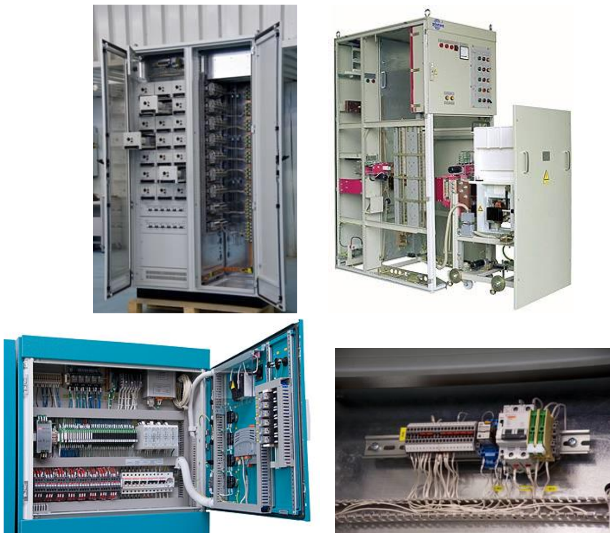
Рисунок 10.11 – Конструкції та основні елементи розподільних пристроїв
