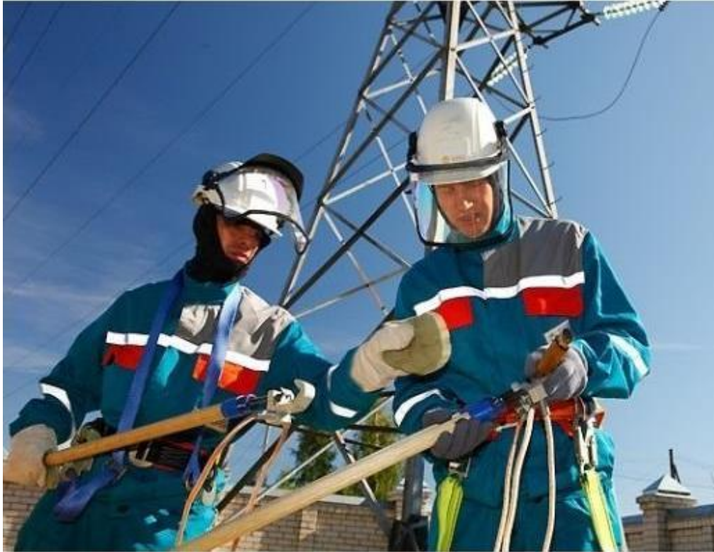
Рисунок 11.6 – Підготовка до роботи на лінії електропередачі
