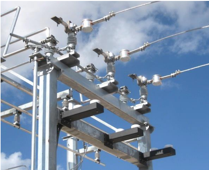
Рисунок 9.8 – Безконтактний вимірювальний перетворювач струму
