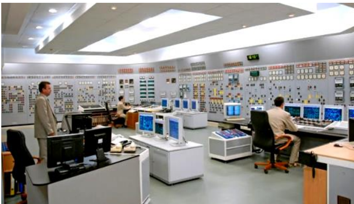
Рисунок 7.1 – Автоматизована система контролю та керування розподілом електроенергії
