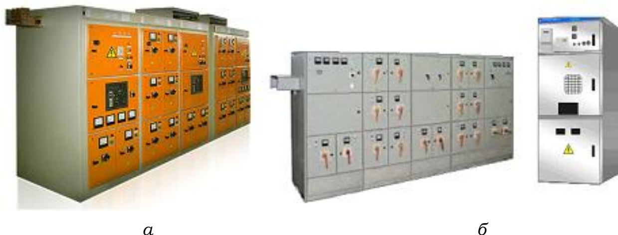
Рисунок 10.7 – Внутрішня цехова комплектна трансформаторна підстанція (а) і розподільні пристрої (б)
