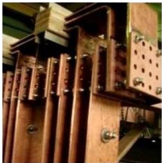
Рисунок 3.16 – Монтажне з'єднання жорстких шин
