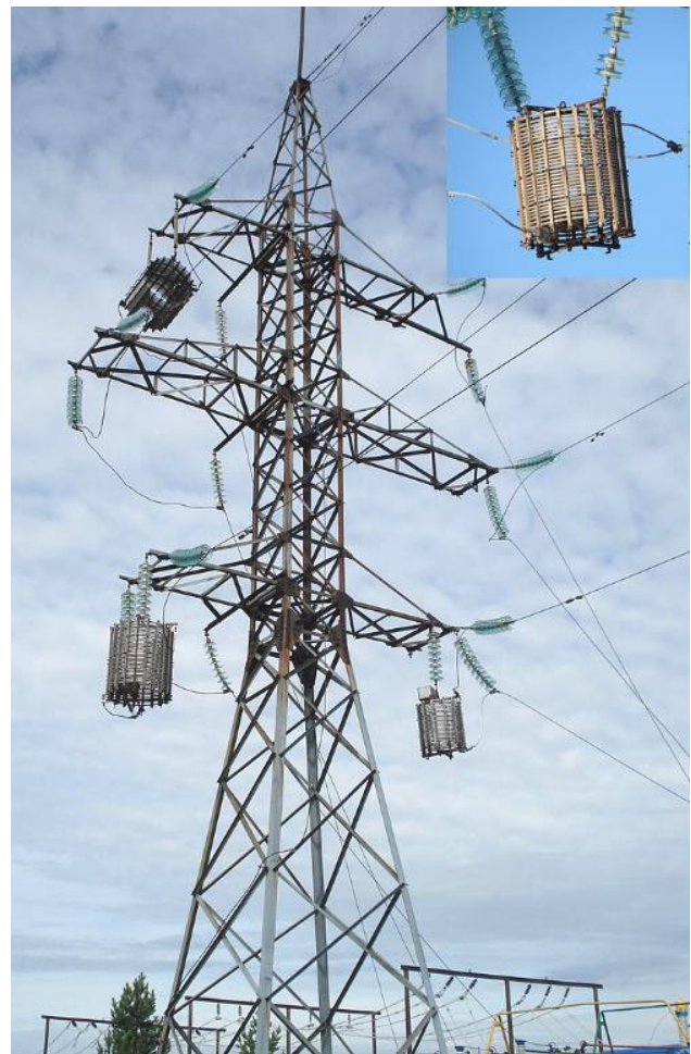
Рисунок 9.12 – Кінцева опора ЛЕП з високочастотними загороджувачами
