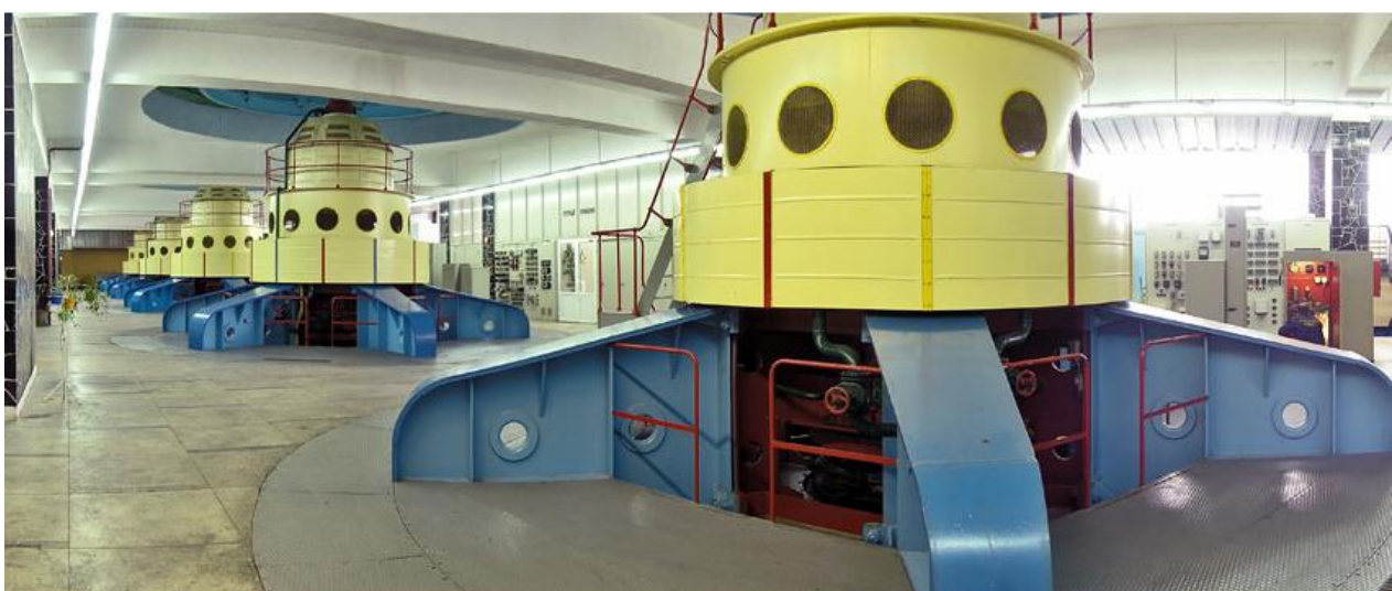
Рисунок 1.9 – Машинний зал ГЕС (видна верхня підвіска гідрогенераторів, а основна їх частина знаходиться під підлогою)
