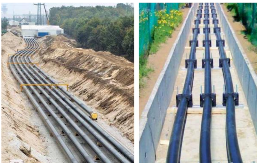
Рисунок 1.18 – Кабельні високовольтні лінії електропередачі: а – в ґрунті на бетонній "подушці"; б – в залізобетонному жолобі
