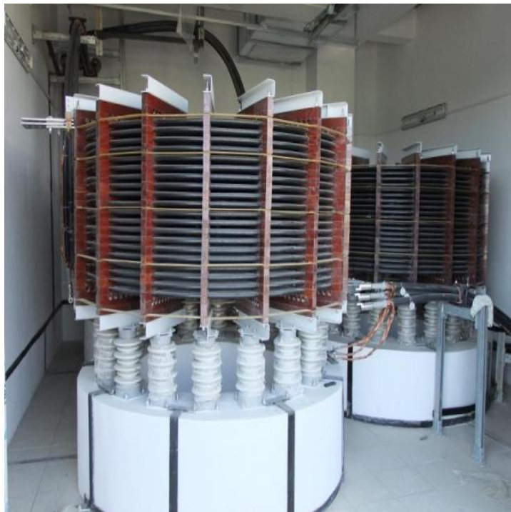
Рисунок 9.9 – Струмообмежувальні реактори
