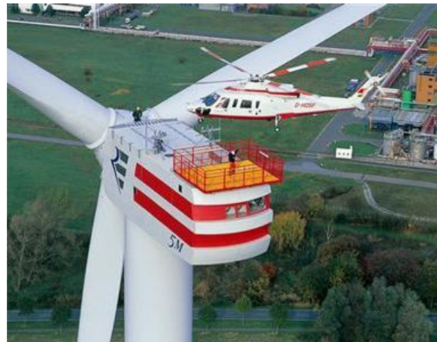
Рисунок 1.12 – Гігантський вітряний електрогенератор потужністю 5 МВт
