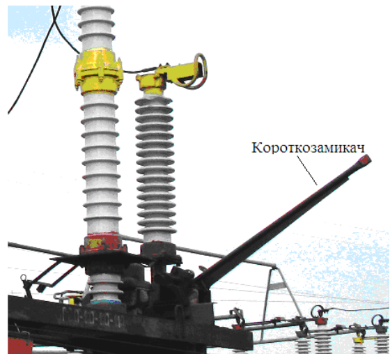
Рисунок 9.5 – Короткозамикач в електричному колі високої напруги
