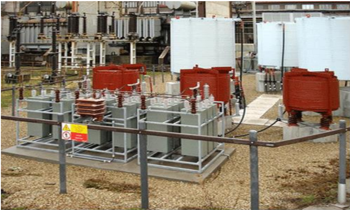
Рисунок 5.17 – Тиристорний компенсатор реактивної потужності
