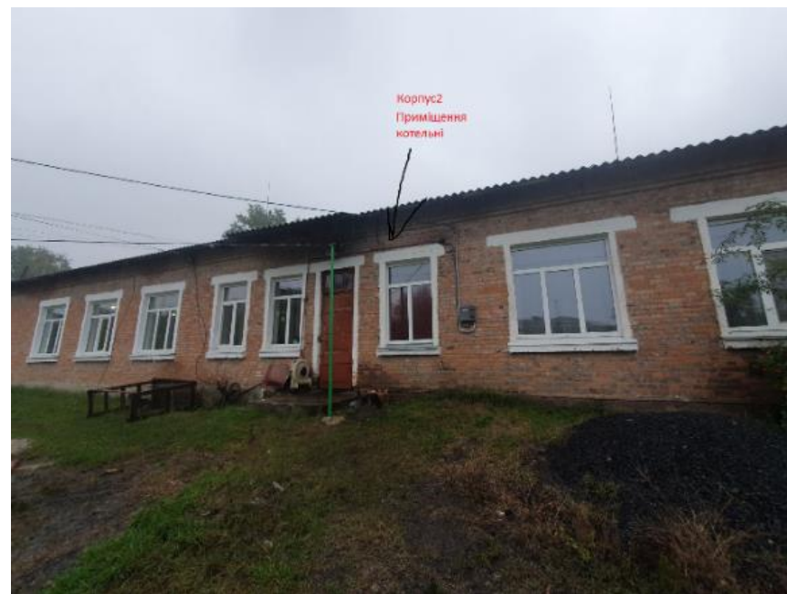
Зображення 2 Корпус 2, приміщення колишньої котельні
