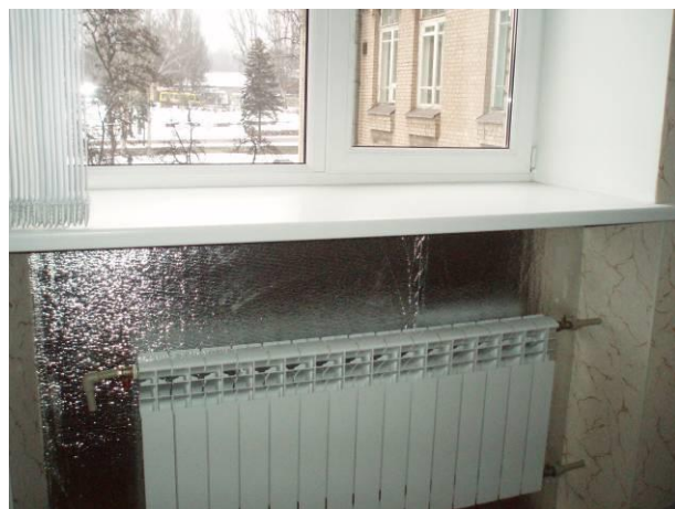
Рис. 4.8. Використання теплових екранів за радіаторами опалення
