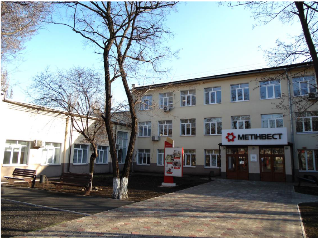
Фото. 1б. Загальний вигляд на центральний вхід в будівлю (ліворуч).
