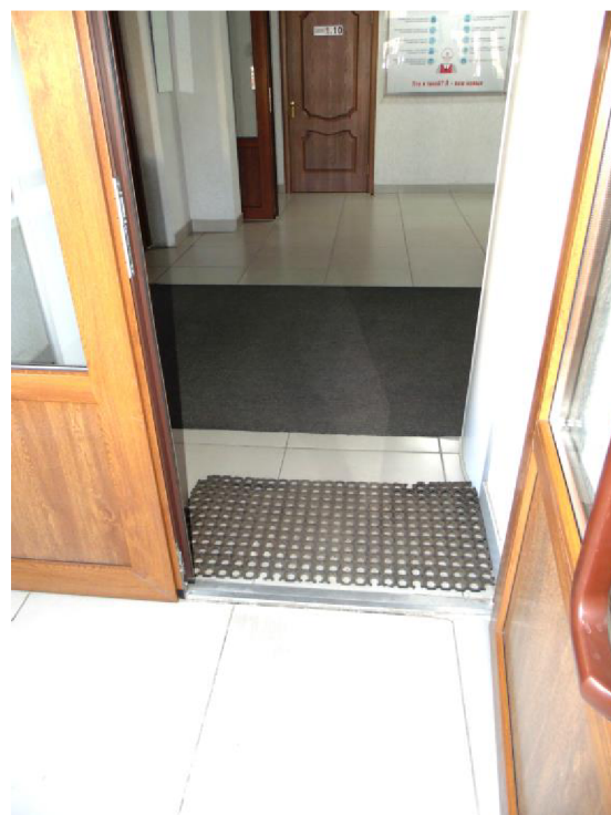
Фото. 8, 9. Загальний вигляд тамбура будівлі «А-3» та входу до будівлі.
