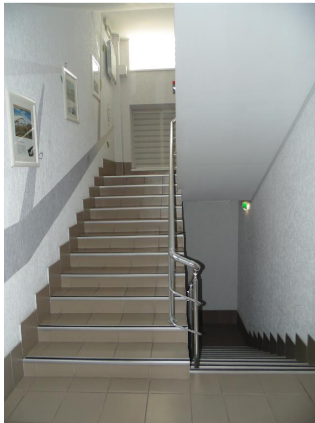
Фото. 12. Головна сходові клітка будівлі.
