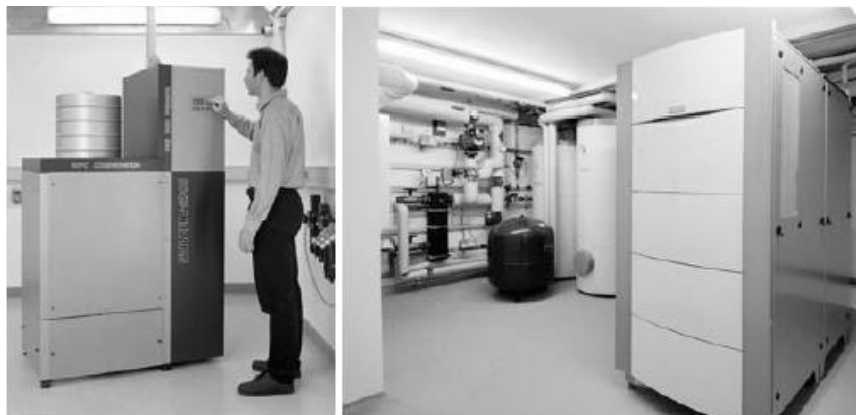
Рис. 14.7. Мікро-ТЕЦ: Sulzer (зліва), Vaillant (зправа)
