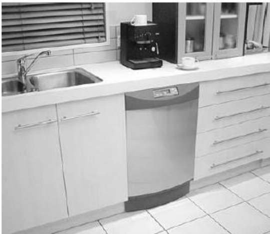
Рис. 14.4. Приклад мікро-ТЕЦ, потужність (ел) 1,2 кВт (WhisperTech).
