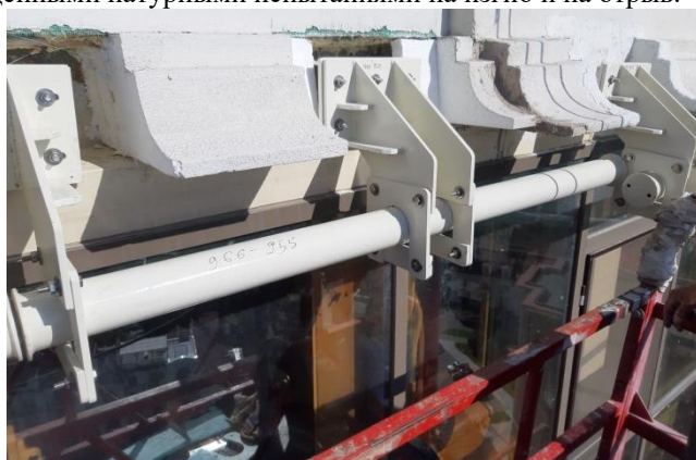
Рис. 3. Система кронштейнов, выполненная в уровне карниза здания
