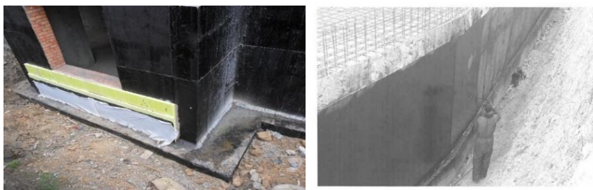
Рис.2. Нанесение битумно-каучуковой мастики, тип «ИЗОБИТ» безвоздушным распылением на объектах
