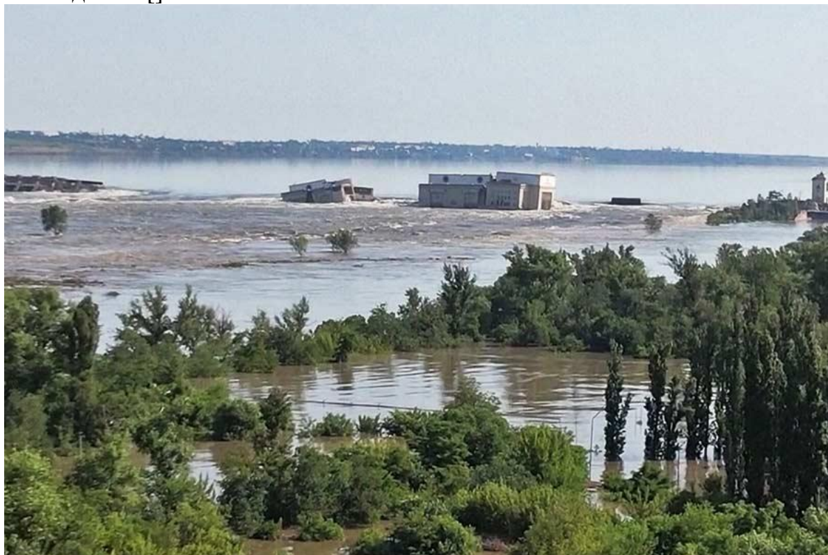
Рис.3 – Наслідки руйнування Каховської ГЕС
