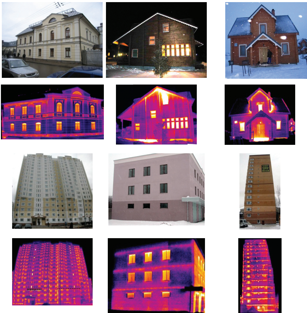
Рис. 4.5. Термограми і фотографії фасадів будівель, отримані при тепловізійному обстеженні
