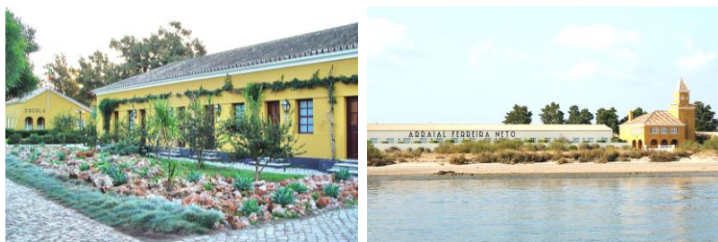
Рис. 1. Еко-готель “Eco Hotel Vila Galé Albacora” в місті Тавіра (округ Фаро, регіон Алгарве, Португалія) [2]
