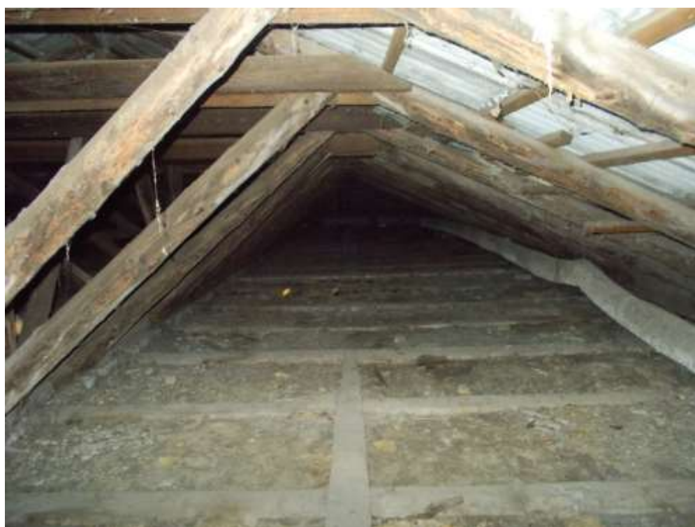
Рисунок 3 – Стан горищного приміщення
