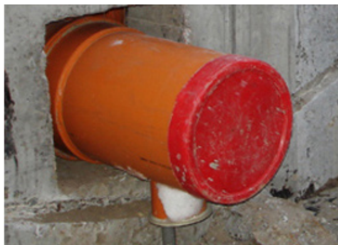
Укладання ґрунтового теплообмінника вентиляційної системи
