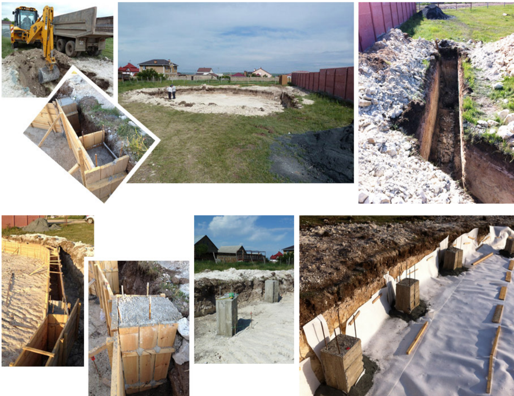
Будівельні роботи при влаштуванні «пасивного» екобудинка
