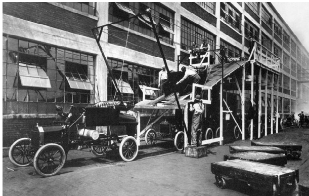
Рисунок 4.31 – Останній етап складання автомобілів на конвеєрі заводу Форда (початок ХХ ст.)
