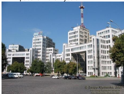
Зразок стилю конструктивізм – будинок Держпрому у Харкові
