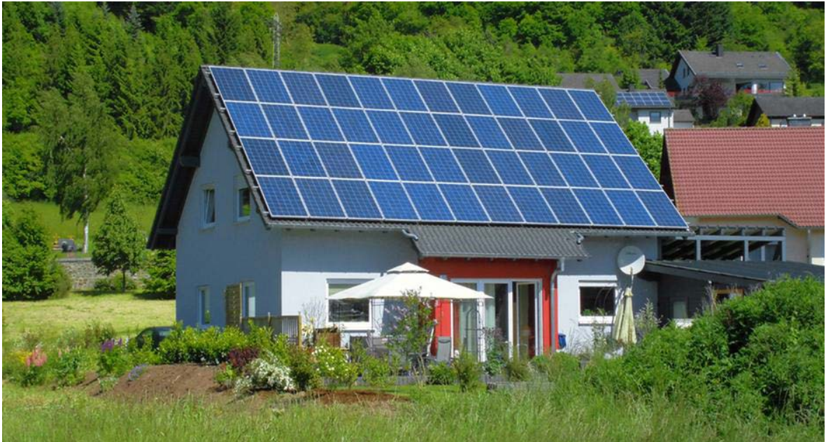
Рис. 2.12. Приклад застосування батарей фотогальванічних елементів.
