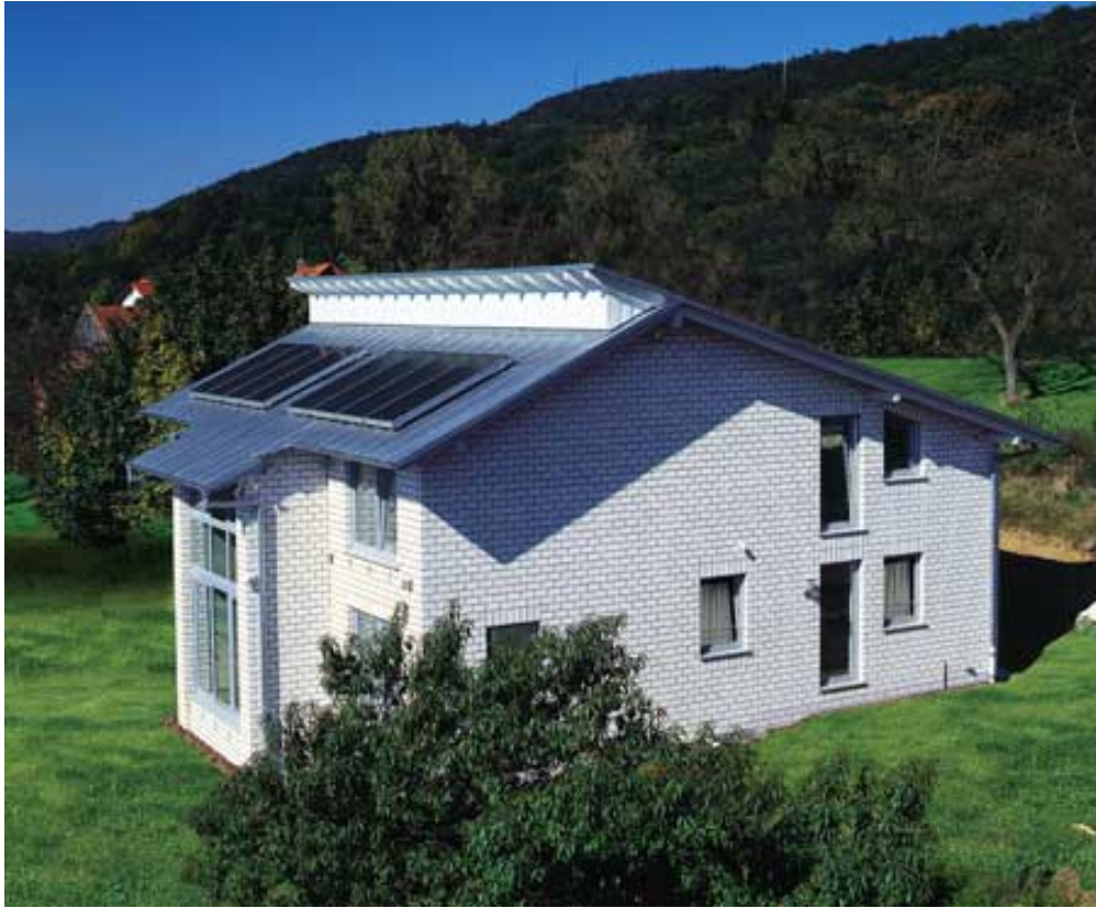
Рис.2.13. Будинок, обладнаний сонячними колекторами.
