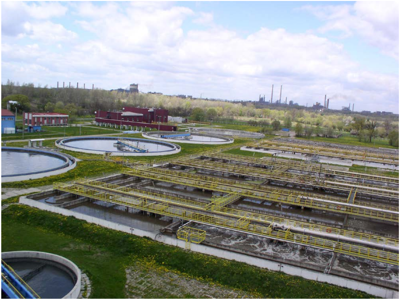
Рис. 11.7. Загальний вигляд комплексу очисних споруд
