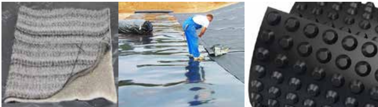
Рис. 3. Гідроізоляція дна (водонепроникна основа) полігона ТПВ.
