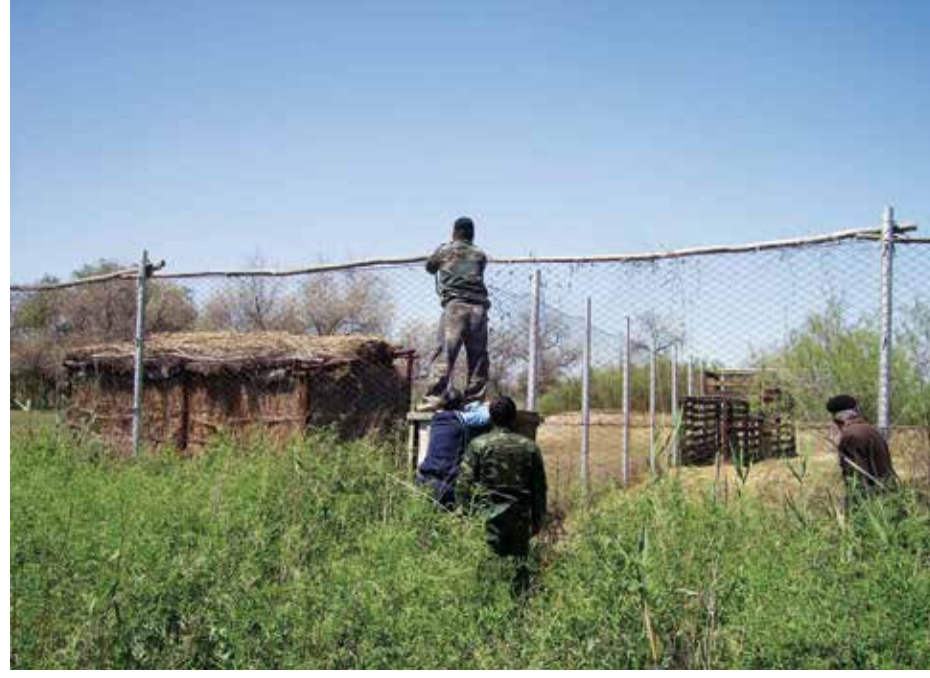
Ремонт системы вольер с укрытием и огловым коридором – Туркестан, Казахстан (фото Байдагетов)
