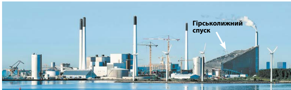
Мал. 38.3. Сучасний сміттєспалювальний завод Amager Bakke у Копенгагені перероблює сміття на теплову й електричну енергію і є місцем відпочинку
