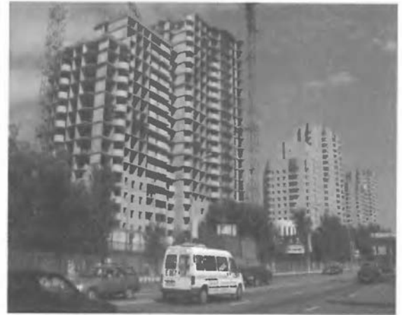
Конструктивные системы, используемые в индустриальном домостроении: 1 — каркасная; 2 — с неполным каркасом; 3 — стеновая; 4 — с возведением методом подъема этажей; 5 — объемно-блочная; 6 — монолитная (сотовая). На фото: строительство зданий монолитным методом (Москва)
