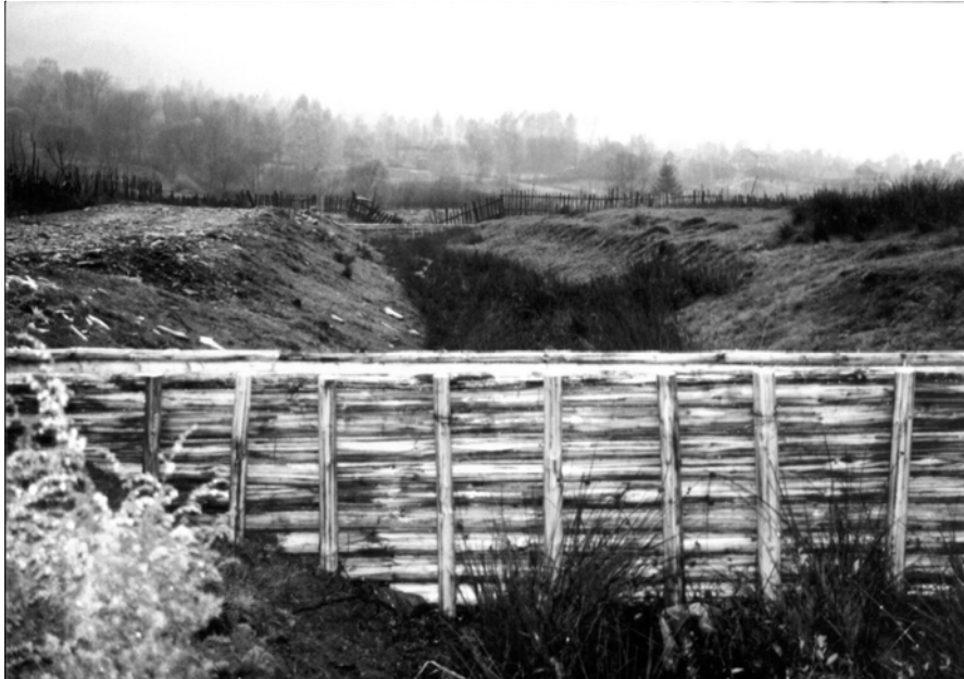
Фото 10. Водозатримуюча загата на головному меліоративному каналі заповідного болота «Глуханя» (НПП «Синевир» – жовтень 2002)
