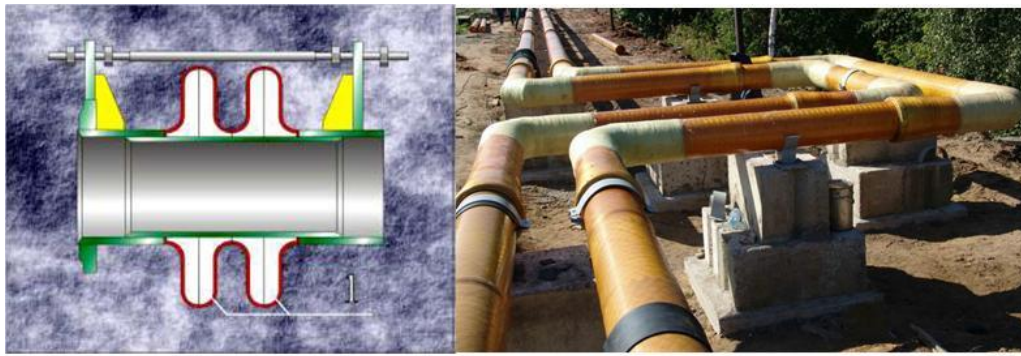
Рисунок 5.2.4 – Компенсатори на газопроводі: А) лінзовий; Б) п-подібний
