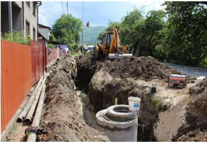
Рисунок 3.2.5 – Каналізаційний колодезь : А) будівництво споруди; Б) елементи конструкції
