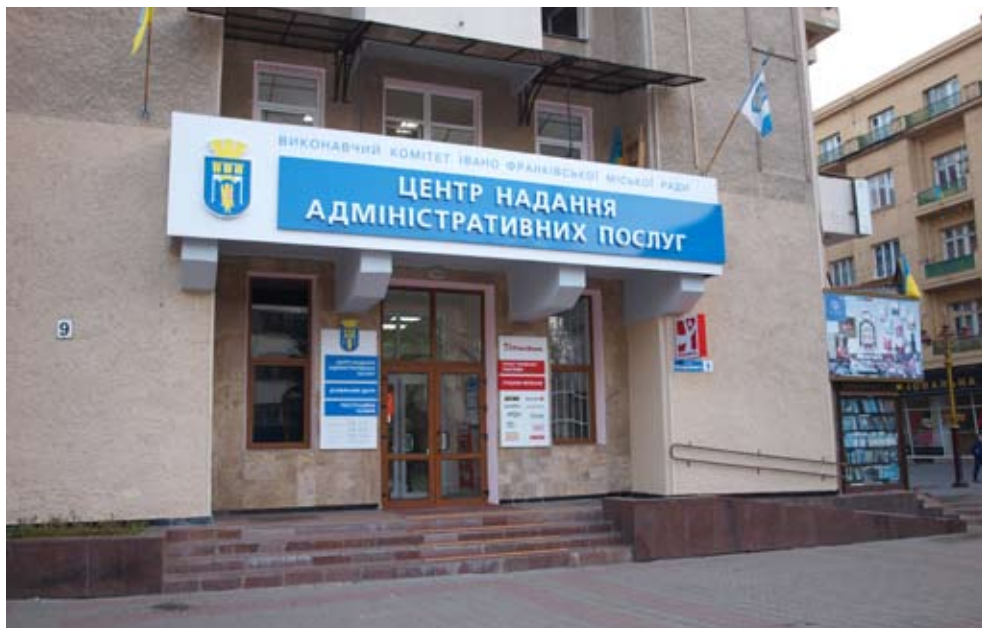
Будівля центру надання адміністративних послуг м. Івано-Франківськ.
