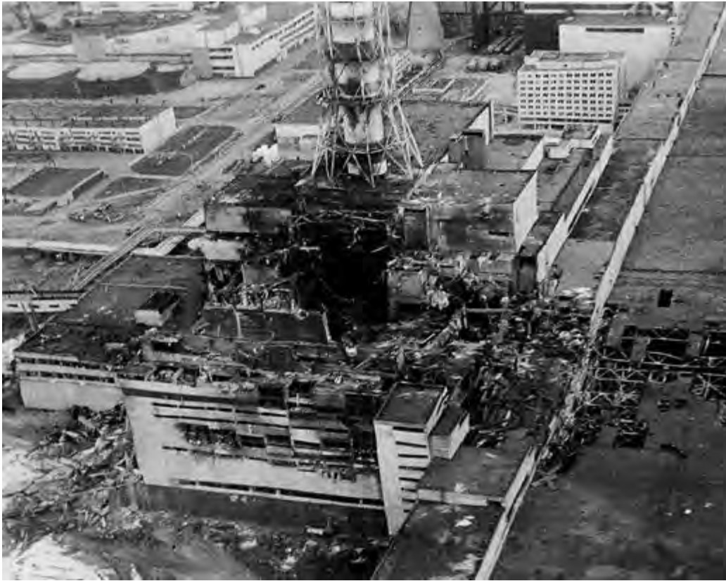
Рис. 30.2. Четвертий реактор Чорнобильської АЕС після аварії
