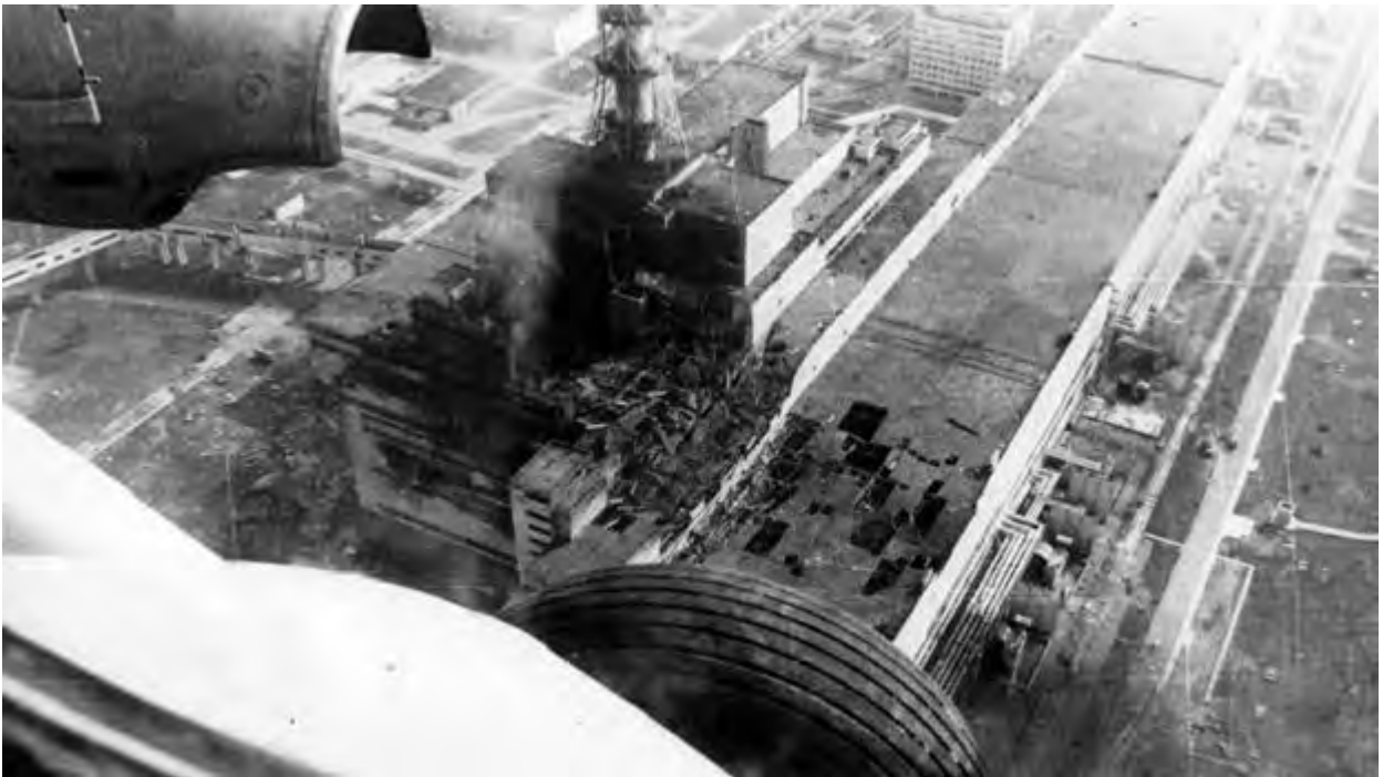
Рис. 30.3. Четвертий реактор Чорнобильської АЕС після аварії
