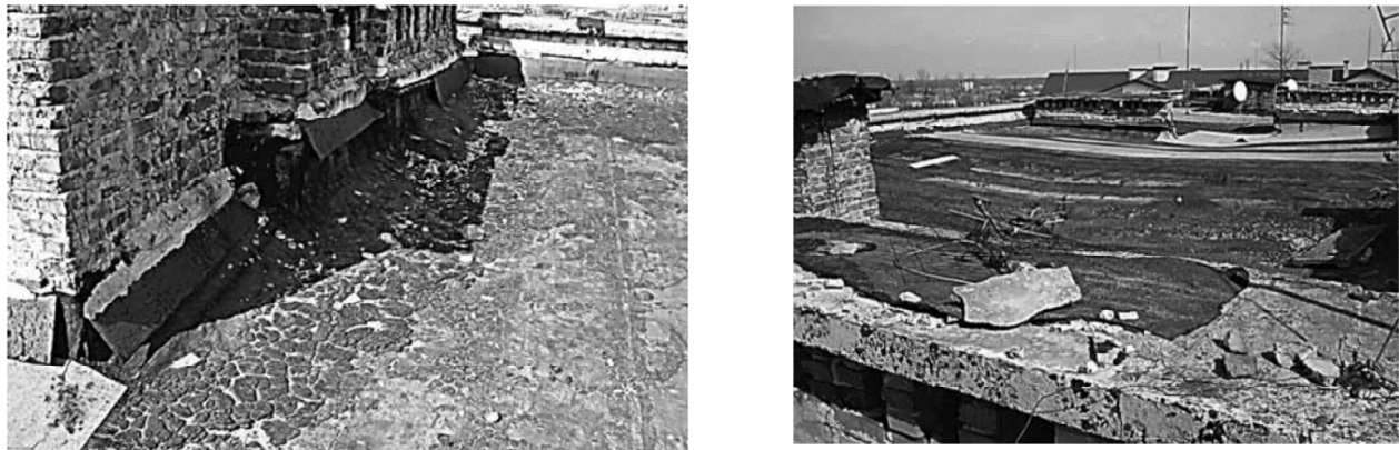
Рис.2.4. Зовнішній вигляд покрівлі з рулонних матеріалів після тривалої експлуатації
