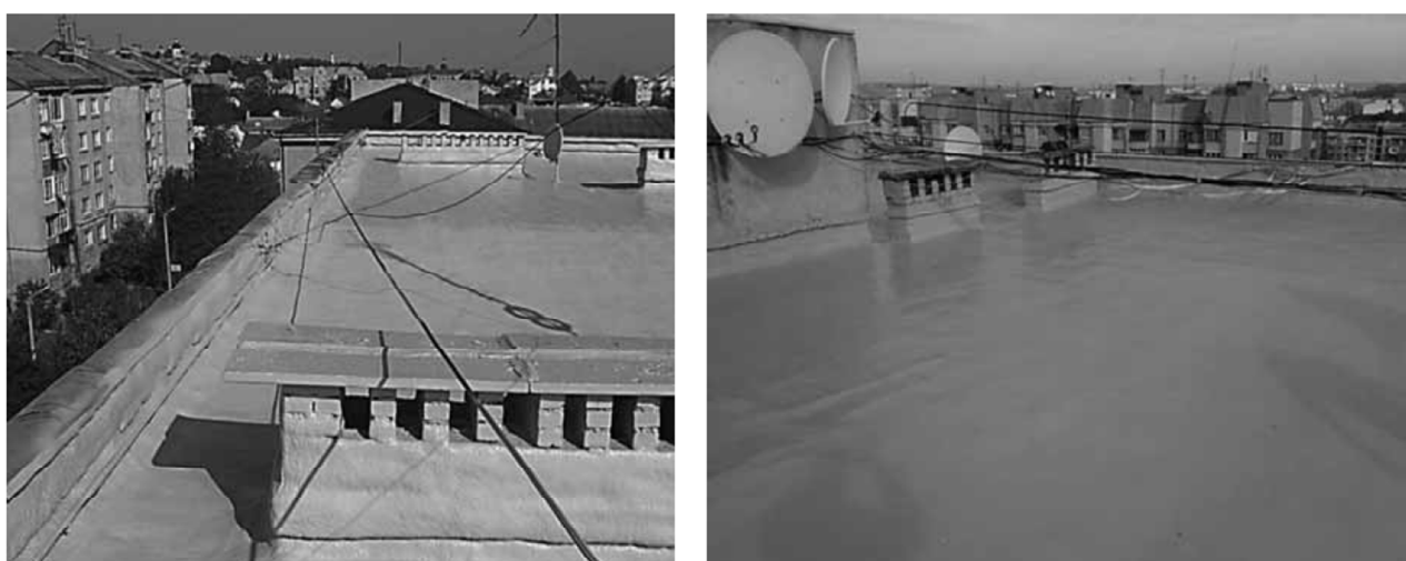
Рис.2.5. Зовнішній вигляд покрівлі, ремонт якої виконаний із застосуванням приладів інфрачервоного опромінення та з улаштуванням багатошарового монолітного теплоізоляційного покриття із пінополіуретану
