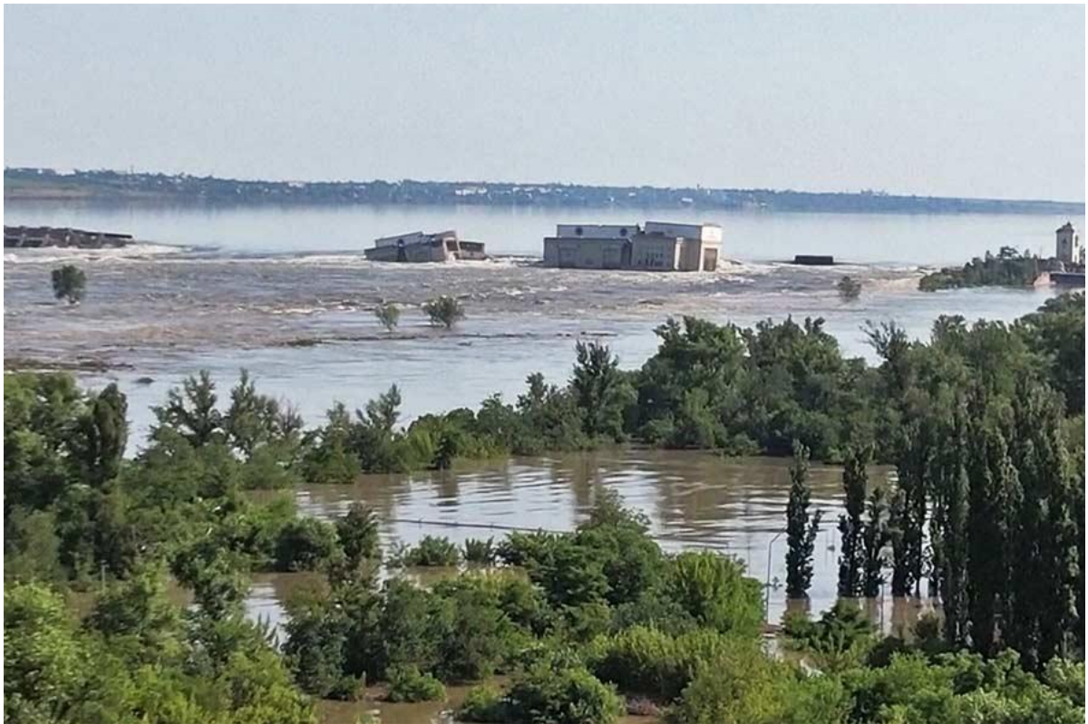
Рис.3 – Наслідки руйнування Каховської ГЕС
