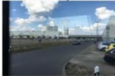
Abwasserbehandlung Industriekomplex SP
