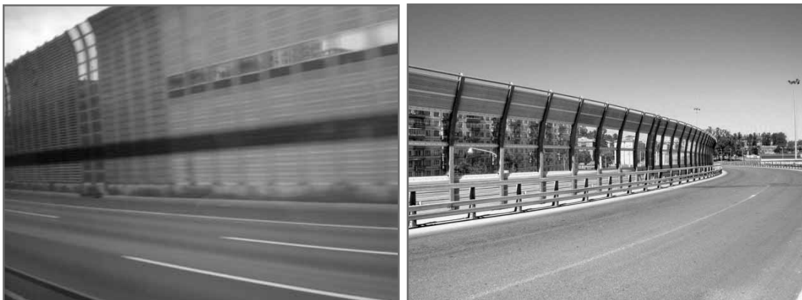
Фото 20,21. Зліва, антишумовий бар'єр висотою близько 8 м. Сеул, Південна Корея, справа – бар'єр з вмонтованими «сонячними фотоелементами», околиця міста Дордрехт, Нідерланди. (Фото: зліва - І.Парасюка, справа: за матеріалами сайту: http://greenevolution.ru )
