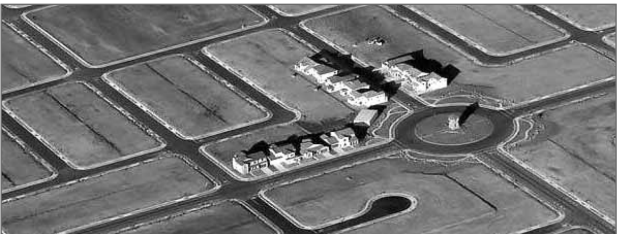
Фото 2. Початок будівництва котеджного містечка (за матеріалами сайту: http://randomfunnypicture.com/ )
