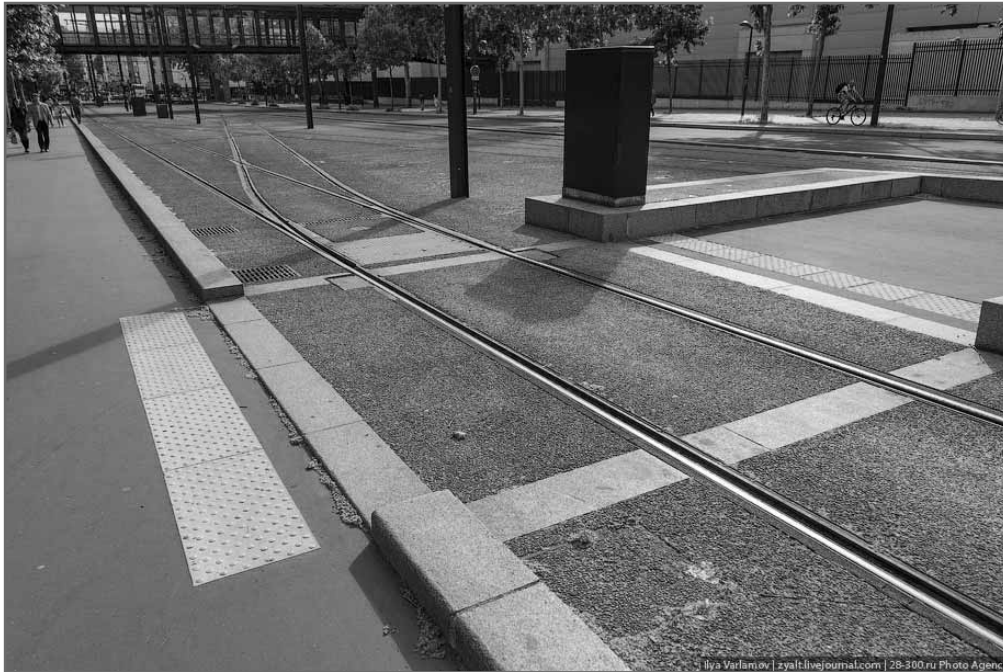
Фото 59. Перехід через трамвайні рейки з попереджувальними рельєфними смугами. Париж, Франція (Фото за матеріалами: http://fotoklumba.lviv.ua/?p=1562 )
