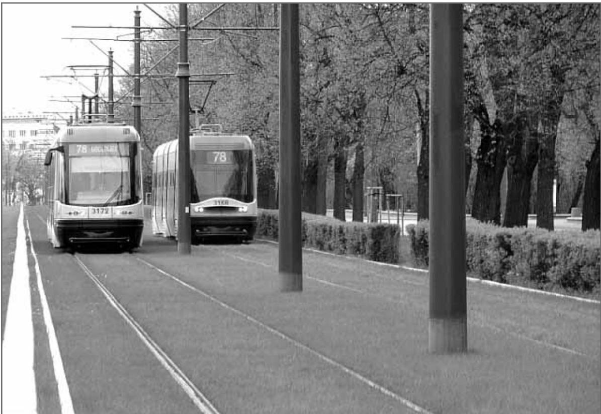
Фото 23. Один з маршрутів варшавського трамваю після реконструкції колії та сучасного озеленення, Варшава, Польща (Фото за матеріалами сайту: http://warszawista.blogspot.com/2013/05/zielone-torowisko-na-zieloneckiej.html#.VcxxFfntmko )
