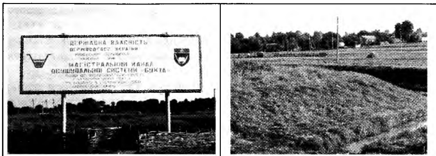
Магістральний канал осушувальної системи «Бухта» (Рівненська обл.)
