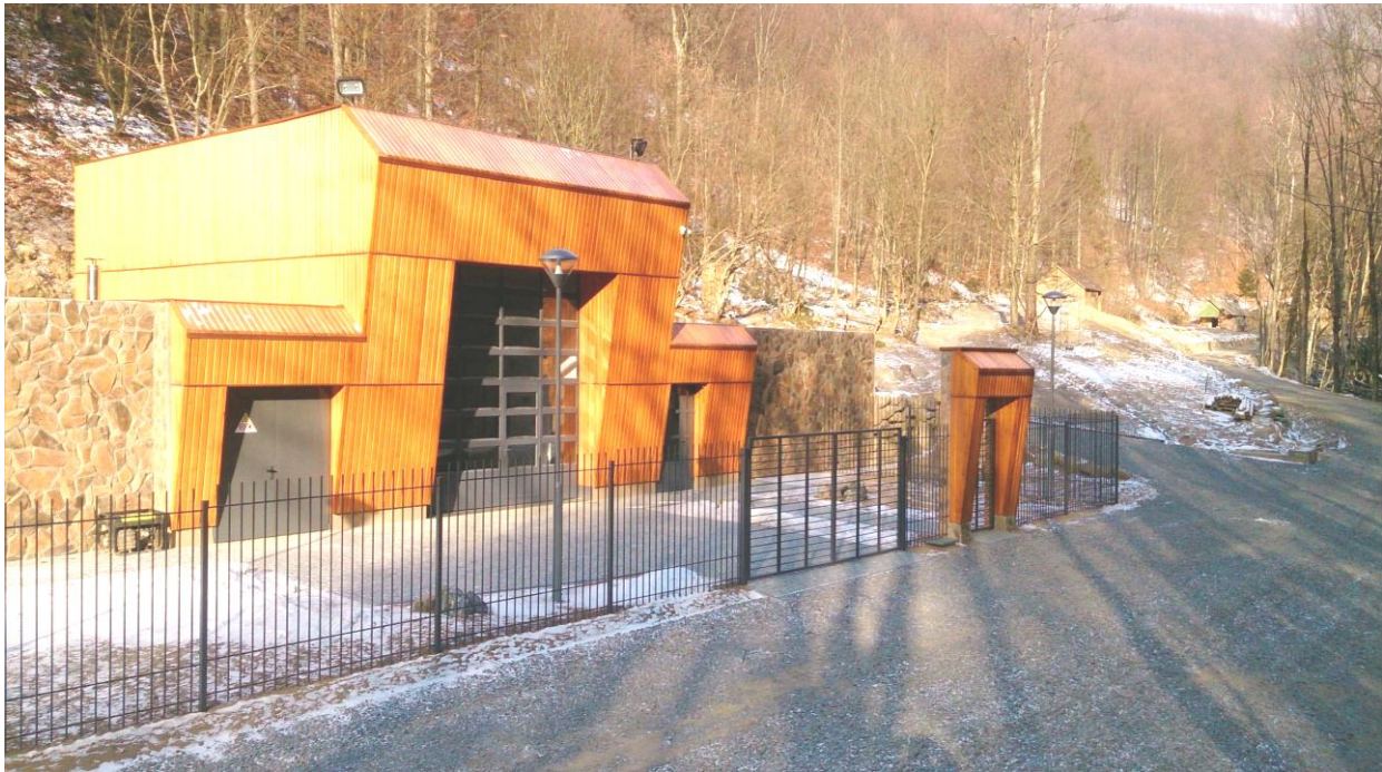
Рис. 2. Будівля високонапірної станції "Шипот-2".
