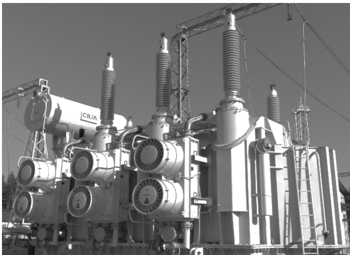
Рис. 1.29. Силовий двообмотковий трансформатор: а – загальний вигляд; б – Г-подібна схема заміщення трансформатора
