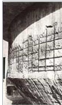
Сучасне зміцнення конструкції за допомогою засобів Максрест методом торкретування
