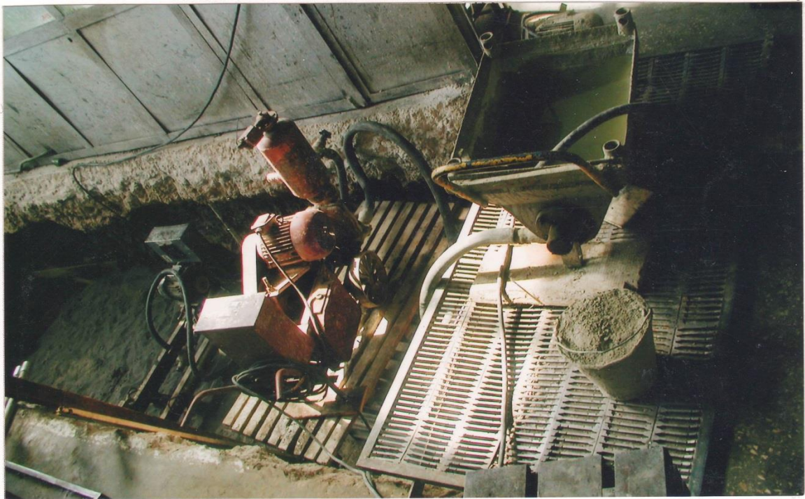
Рис. 2.6 Виготовлення ґрунтозмішувальних паль
