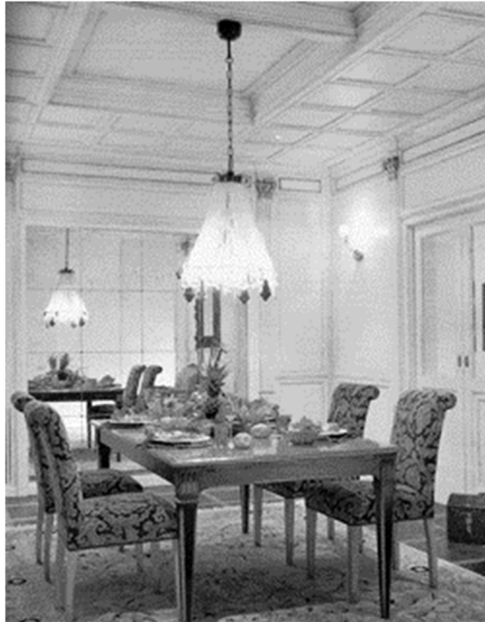
Малюнок 1.4.3 – Використання кесонної стелі, освітлення приміщення
